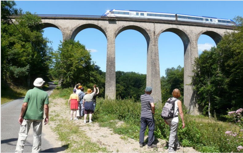
Viaduc de La Perrière (@OTVALDESIOULE)
