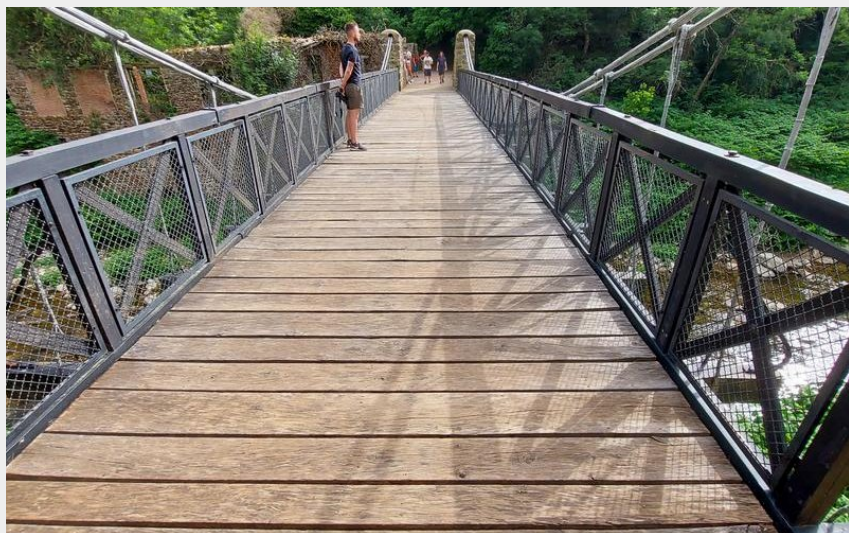
Pont moulin sur la Cance (©AL-ADT07)
