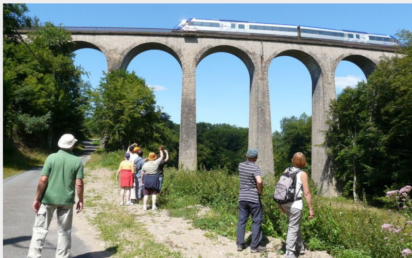
Viaduc de La Perrière (@OTVALDESIIOULE)
