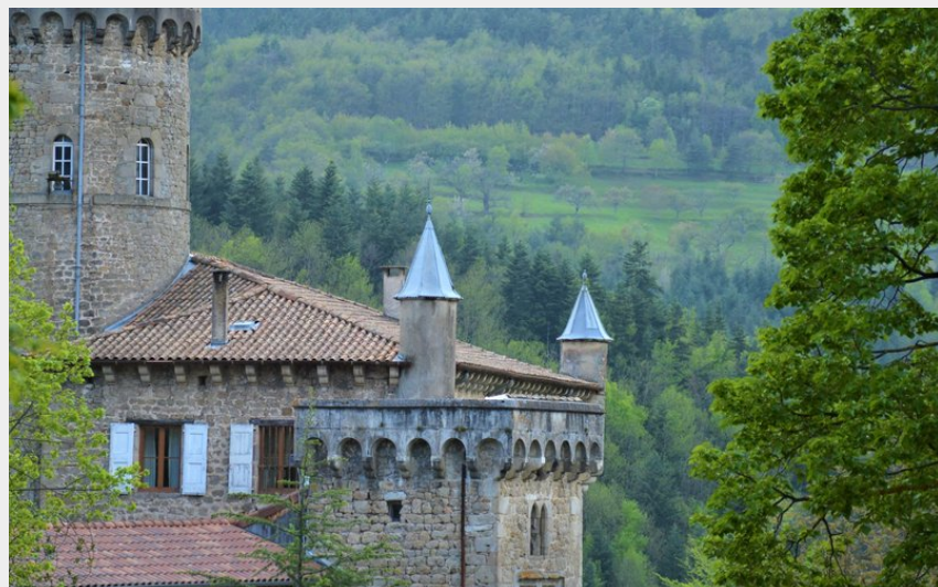
Château du Vergier (OT Pays de Lamastre)
