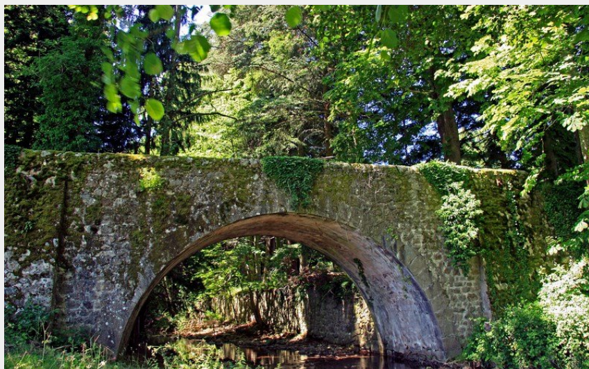
Pont (Mairie de Gilhoc)
