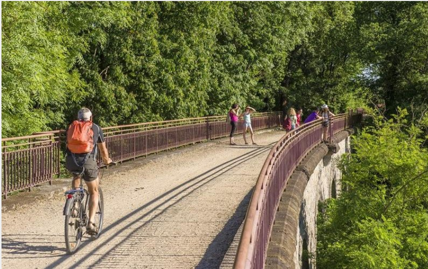
Passage sur le viaduc de Nérís (Luc OLIVIER)
