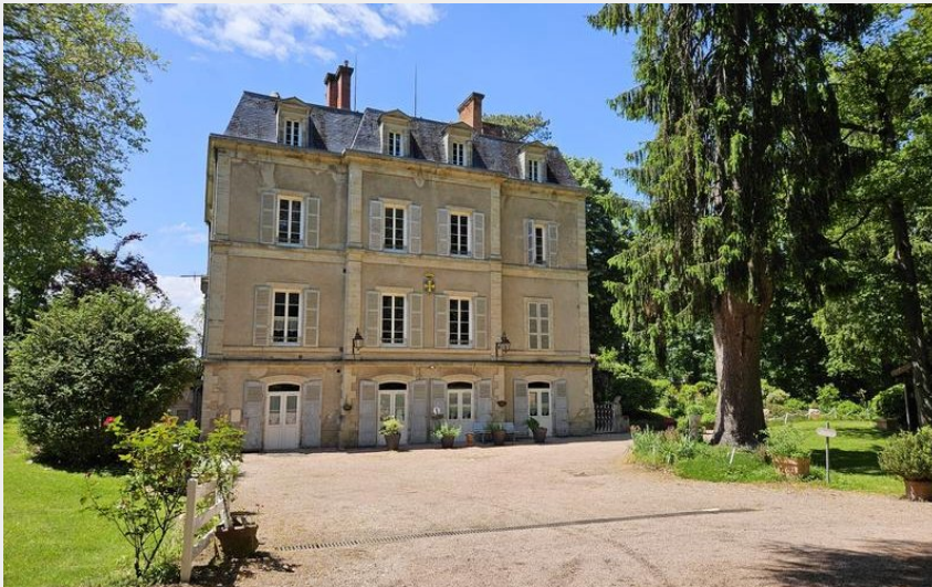
Crédit : Façade (Montsablé)
