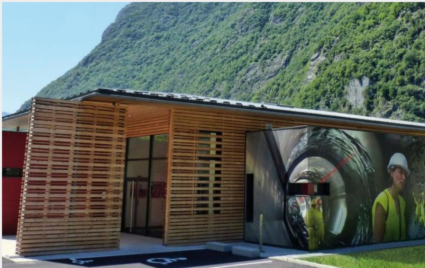
Crédit photo : L'extérieur du bâtiment (Maison Romanche Energie)
