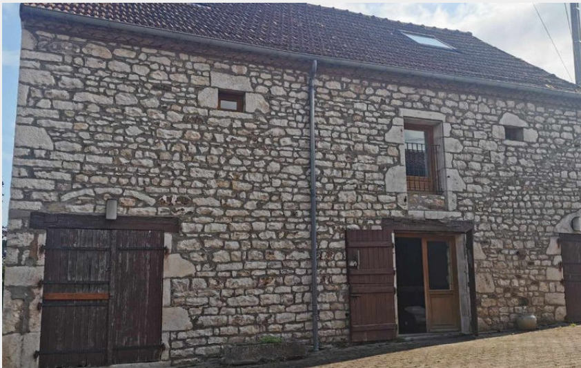
Crédit photo : Façade (Sancelme Michèle)
