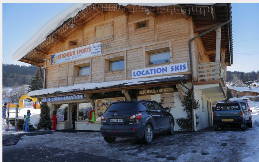
Crédit : FACADE_2019 (FACADE_2019)
